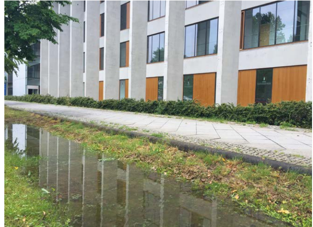
Figure 64 Rétention et infiltration lente à Adlershof
