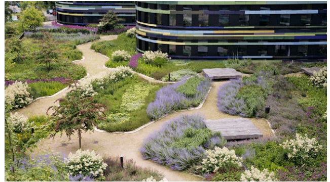
Figure 70 Toiture végétalisée intensive au-dessus du garage souterrain de l'Administration de l'environnement et de l'énergie à Hambourg
