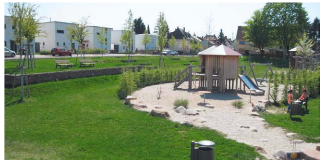
Fig. 31 : Knielingen : le parc central est en même temps une surface de rétention
