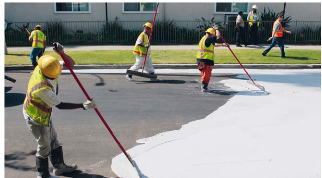
Fig. 82 : Repeindre une rue avec un enduit réfléchissant permet de réduire la chaleur qu'elle restitue – Le projet pilote « Cool Pavement » à Los Angeles
