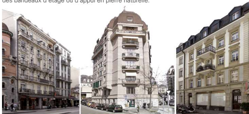
Fig. 17 à 19 de gauche à droite. Bâtiment construit en 1901 à Genève (étude de cas 01), bâtiment construit en 1912 à Genève, bâtiment construit en 1899 à Fribourg.
