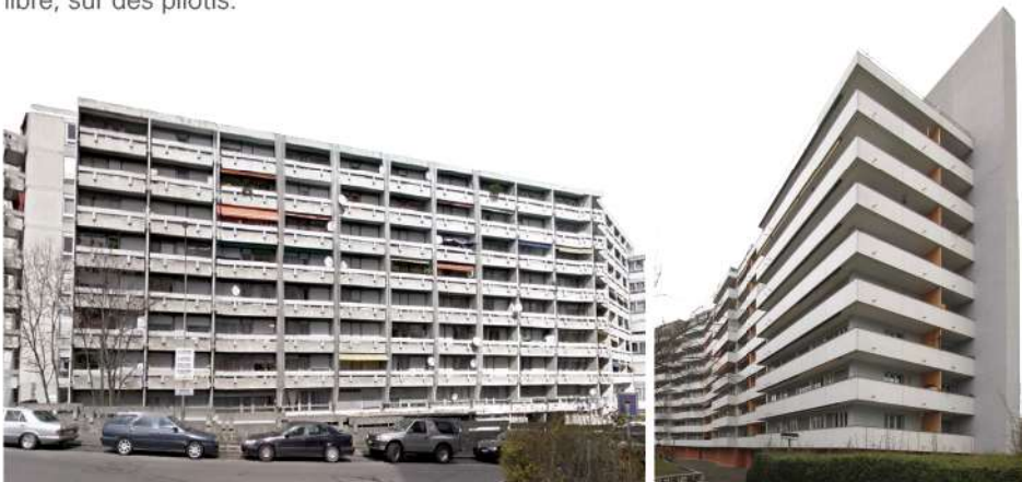
Fig. 31 et 32 de gauche à droite. Bâtiment construit en 1970 à Chêne-Bougeries, bâtiment construit en 1971 à Onex.
