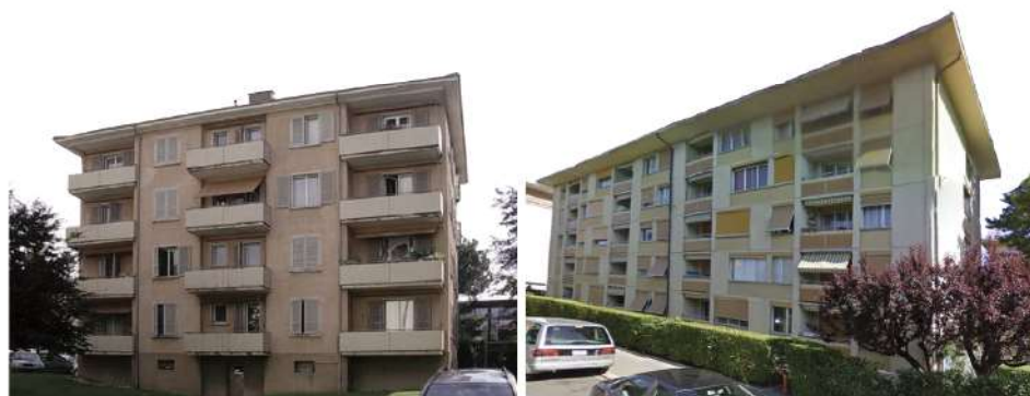
Fig. 27 et 28 de gauche à droite. Bâtiment construit en 1954 à Renens, bâtiment construit en 1954 à Lausanne.
