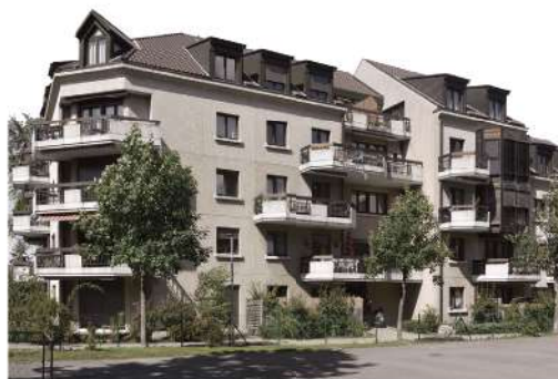
Fig. 41 et 42 de gauche à droite. Bâtiment construit en 1987 à Fribourg, bâtiment construit en 1988 à Genève (étude de cas 10).
