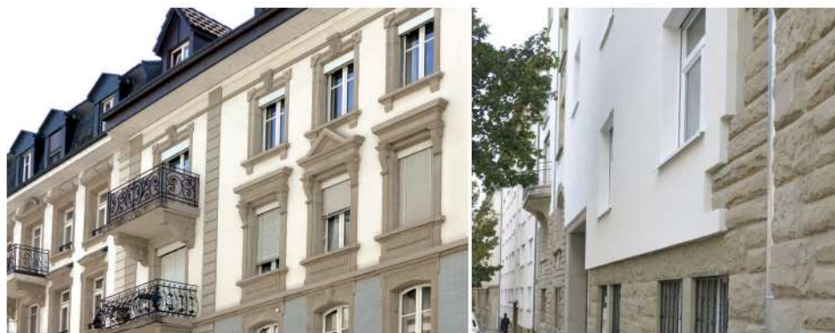
Fig. 45 et 46. À droite, les conséquences d'une isolation périphérique non réfléchie sur les caractéristiques architecturales d'un bâtiment. À gauche, un autre bâtiment montrant les caractéristiques architecturales perdues dans le second.
