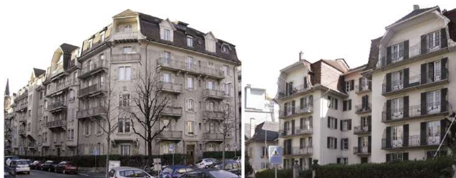
Fig. 20 et 21 de gauche à droite. Bâtiment construit en 1911 à Lausanne (étude de cas 02), bâtiment construit en 1915 à Fribourg.
