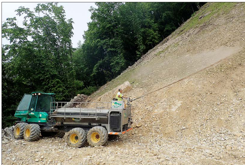
Fig. 2. Projection hydraulique du mélange grainier constitué à l'aide d'une lance à eau (04.05.2015).
