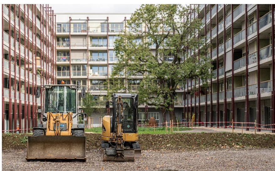
Figure 22 : Machines de chantier dans le Westfeld (photo : Pascal Mora/ARE ©)
