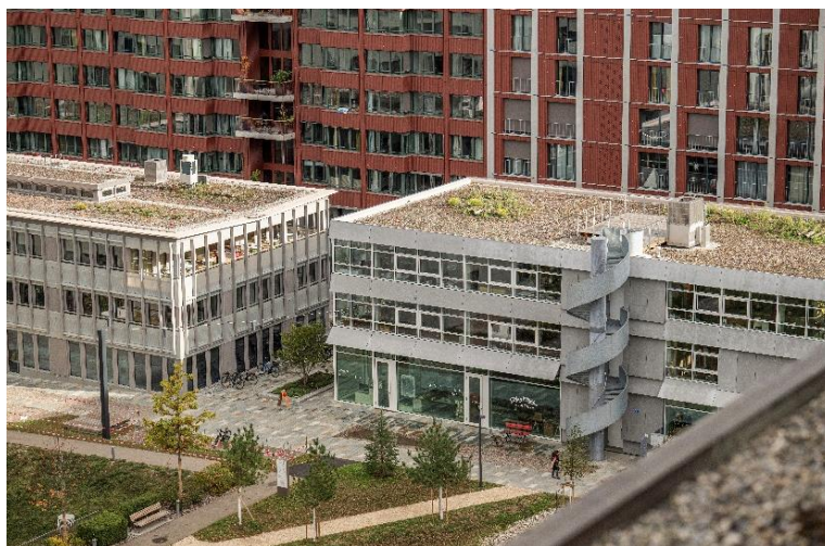
Figure 14 : immeubles sur le site du Westfeld, à Bâle (photo : Pascal Mora/ARE ©)
