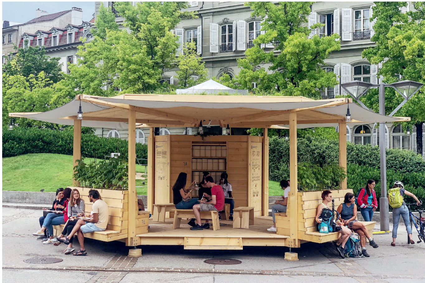
Le pavillon installé en juillet 2021 sur la place Python à Fribourg. Diamètre de la toiture avec le prolongement des toiles d'ombrage : 10 m, hauteur entre le plancher et la toiture : 2,5 m, hauteur maximale : 3,8 m. Sa structure modulaire permet de le démonter, le transporter puis le remonter sur un nouvel emplacement en ~1,5 jours. (JEAN-MICHAËL TAILLEBOIS, HEIA-FR)
