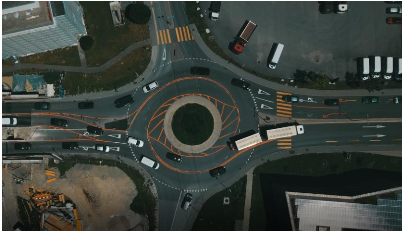
Fig. 16 Lavapesson (travaux OFROU, relevé par drone – RGR, 2018).
