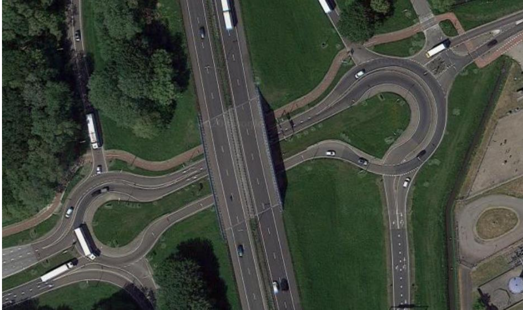
Fig. 10 Turbo-giratoires en goutte à la jonction autoroutière Maasdijk, google.com/maps , 2021.
