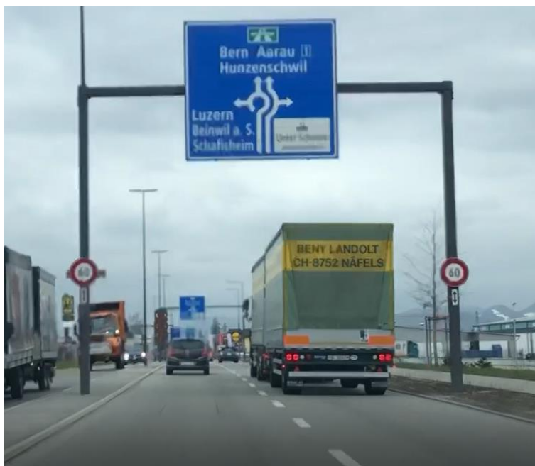
Fig. 53 Exemples de signaux « Indicateur de direction avec répartition des voies pour turbo-giratoires », presque-turbo-giratoire de Seetalstrasse, Lenzburg, 2021.
