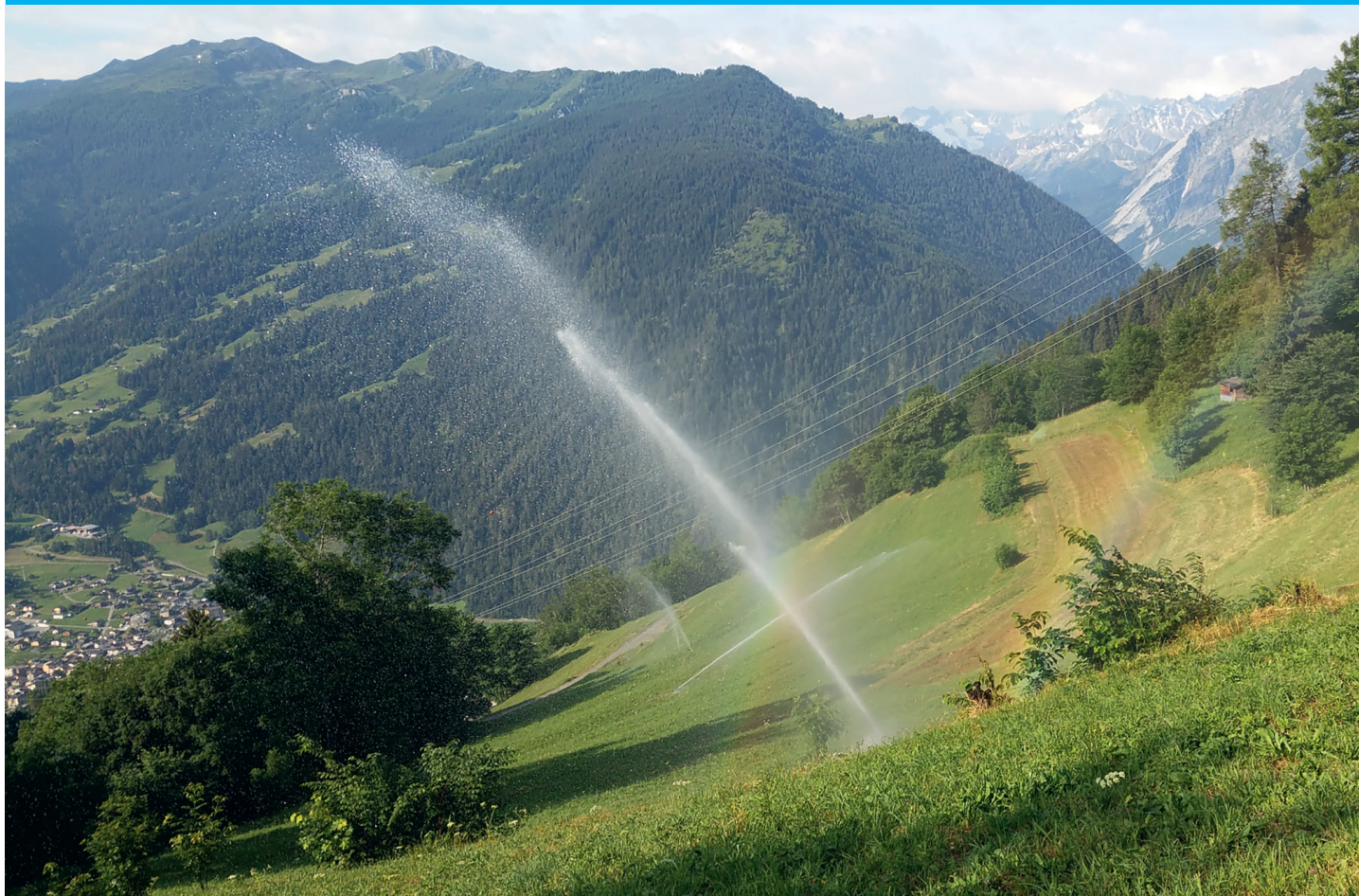
Réseau d'irrigation dans la région de Verbier.
